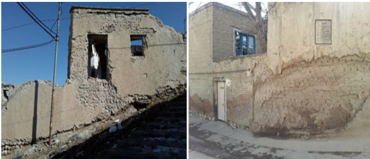
شکل ۱۴. استفاده از مصالح سنگ و خشت و بازشوهای کوچک در خانه‌های بافت قدیم بوکان (مأخذ: نگارندگان)
