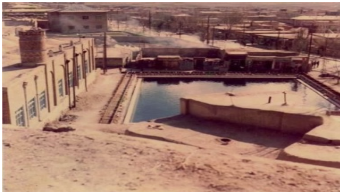
شکل ۱۱. نمایی از حوض‌خانه و مسجد سردار در گذشت، سال ۱۳۳۰ (مأخذ: آرشیو اداره کل میراث فرهنگی، صنایع دستی و گردشگری آذربایجان غربی)
